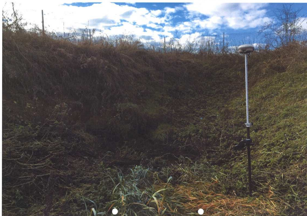
Das vorhandene Rückhaltebecken wird für die Einleitung erweitert und ertüchtigt.
