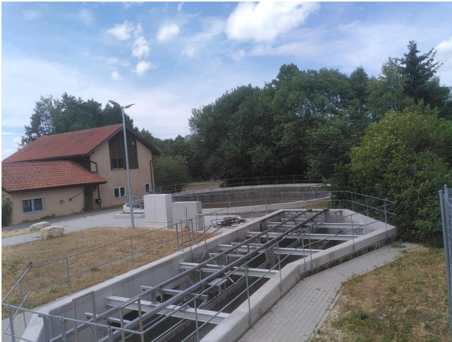
Abb. 3: Blick auf das Kläranlagengelände von Westen
